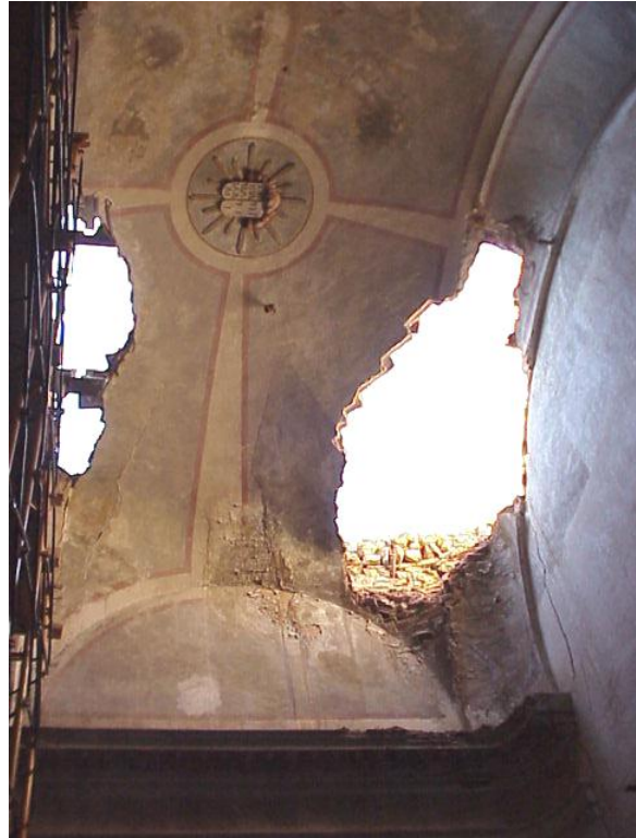
Fig.6 Rotura de la bóveda del presbiterio en noviembre de 2000
