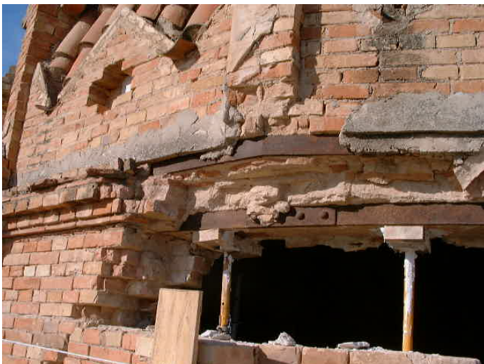
Fig.10 Aparición de los cinchos de hierro que tiene el arranque de la cúpula (abril de 2001)
