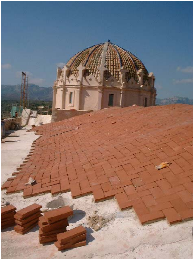
Fig. 15 Colocación del nuevo material de la cubierta (octubre de 2001)
