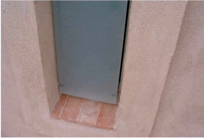
Fig. 17 Detalle del acristalamiento de las ventanas de la cúpula
