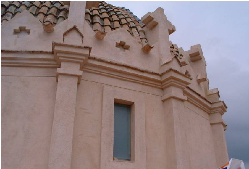
Fig. 16 Detalle del revoco del tambor de la cúpula
