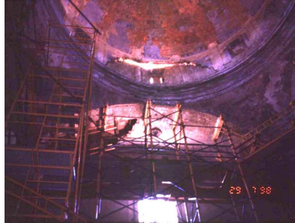
Fig. 3 Interior apuntalado en julio de 1998
