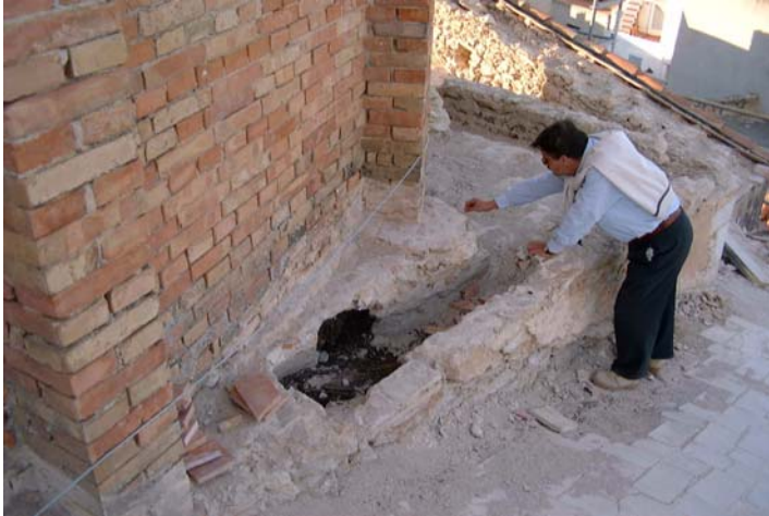
Fig.8 El arquitecto Arturo Zaragoza observando los huecos de los durmientes de madera podridos en la base de la cúpula (marzo de 2001)
