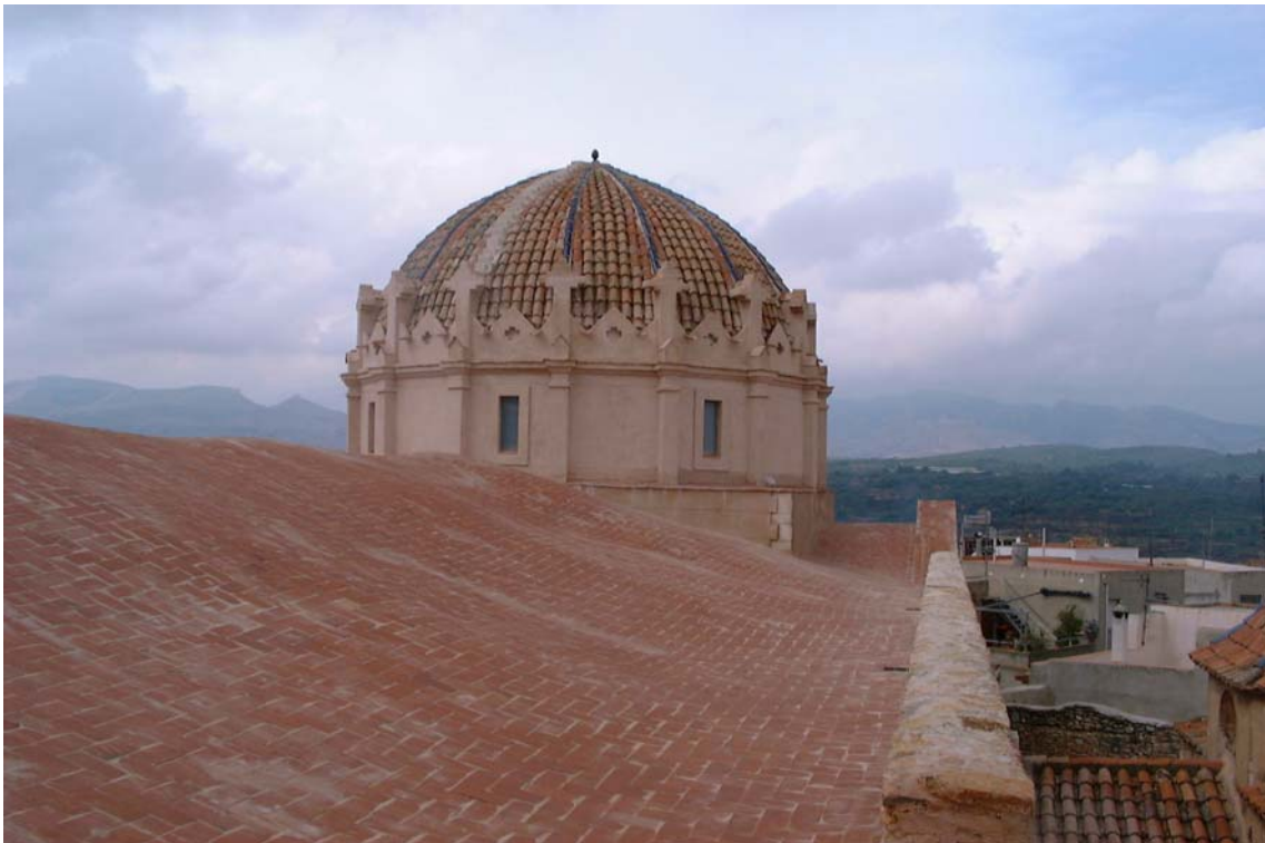
Fig. 19 Vista de la cubierta terminada (noviembre de 2001)
