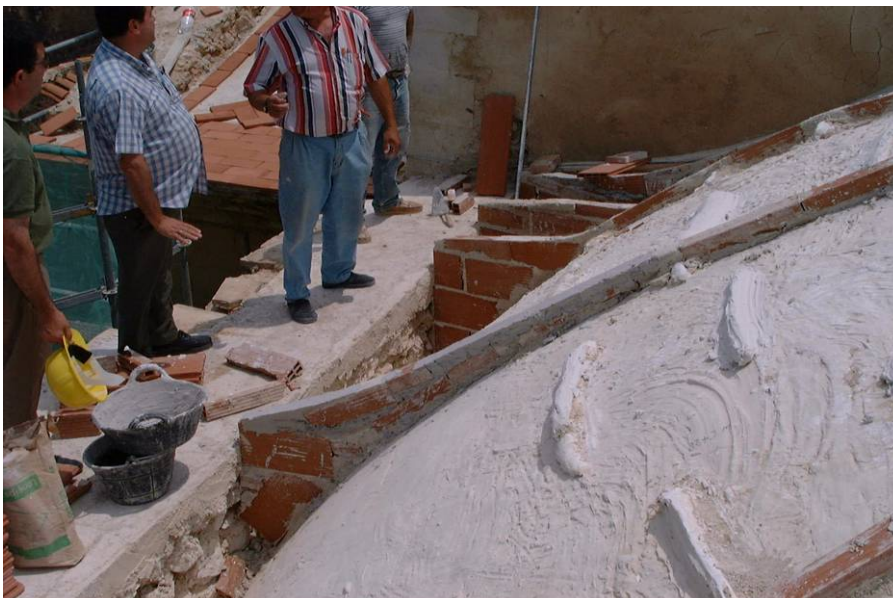
Fig. 13 Bóveda del presbiterio reparada (junio de 2001) con tabiquillos para recibir la cubierta
