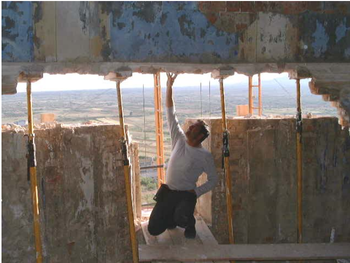
Fig.8 El arquitecto Arturo Zaragoza observando los huecos de los durmientes de madera podridos en la base de la cúpula (marzo de 2001)
