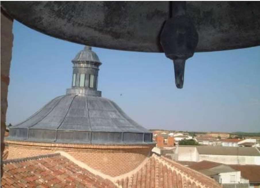
La cúpula tras la consolidación y la nueva cubierta de plomo.
